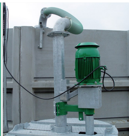
Gylleoverførsel fra fortank til lagertank
